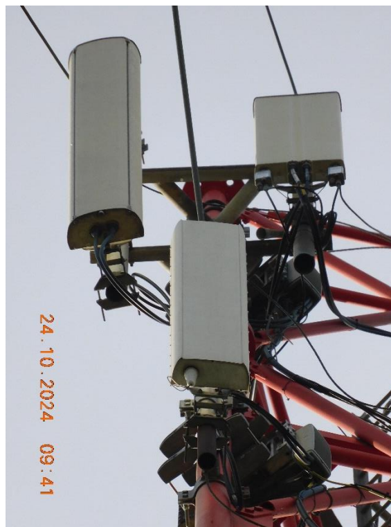
Slika 4: Prikaz antena i radio modula sektora 1
