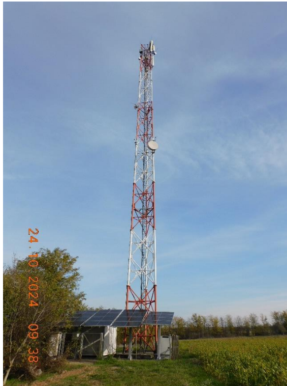
Slika 3: Prikaz antenskog stuba na kom se nalazi bazna stanica
