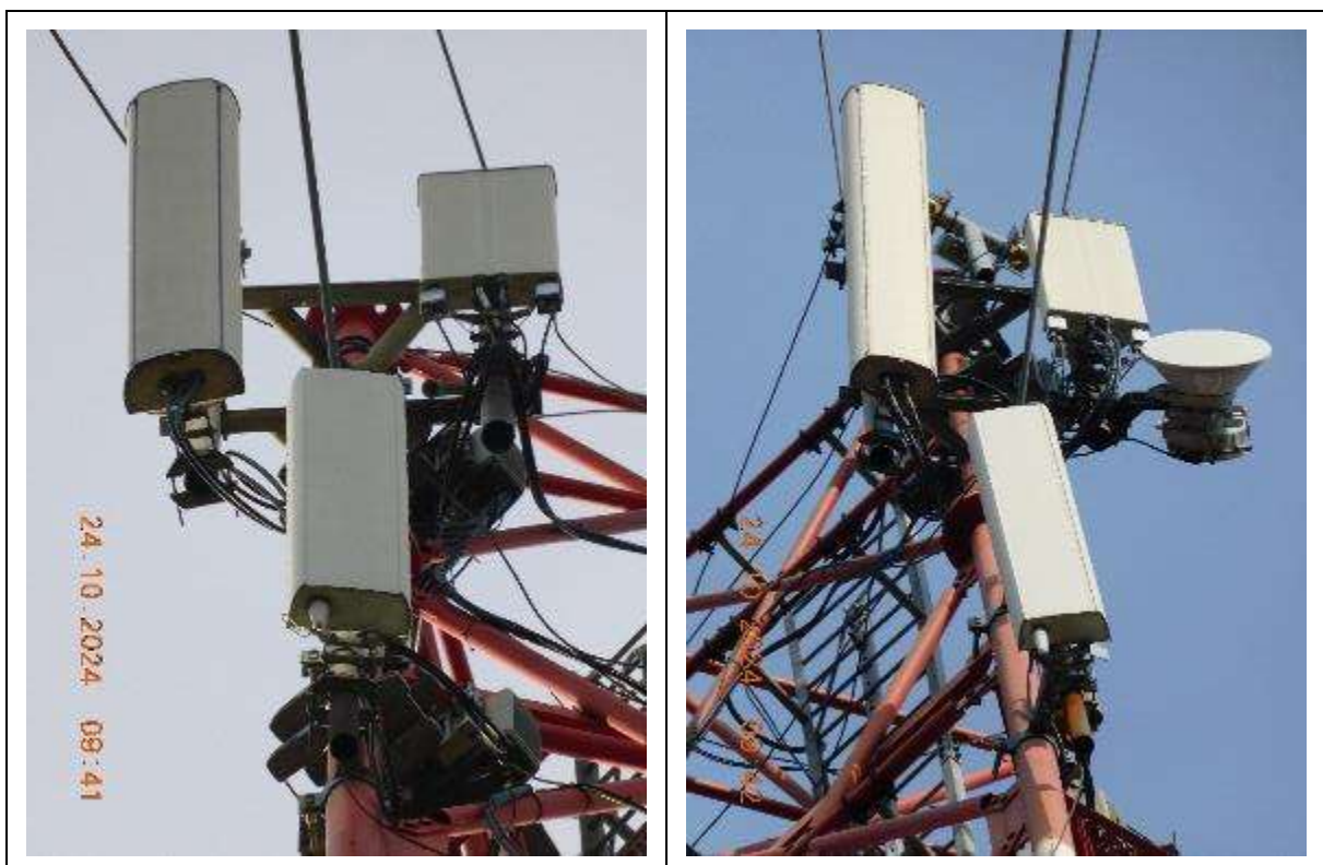
Slika 2.4 Prikaz antenskog sistema bazne stanice
