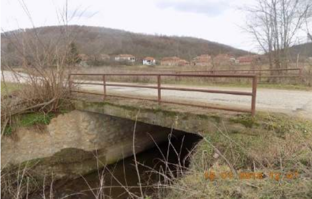
Мост на Ражањској реци – село Маћија
